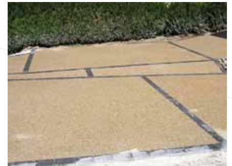
Sol en béton désactivé
